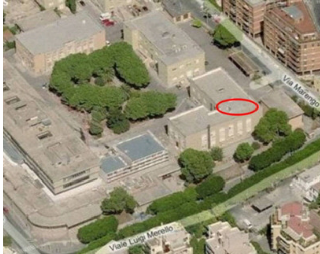
Fig. 4. Cagliari, sede del DiArch la cui copertura accoglie le camere di prova
